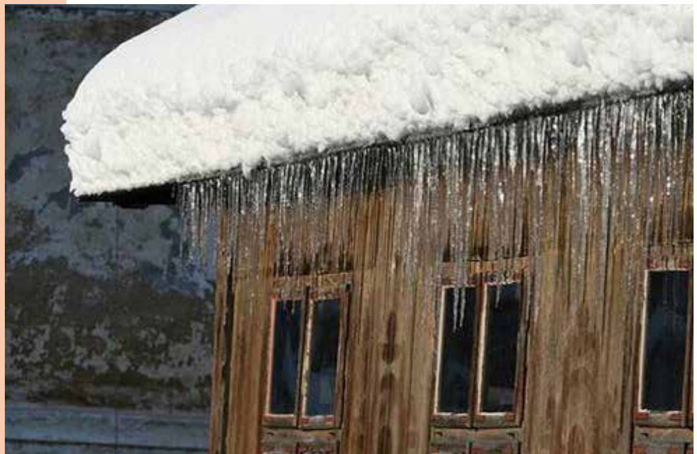
SLIKA 9: LEDENE SVEČE POKAŽEJO OGROMNE TOPLOTNE IZGUBE STAVBE, KI SO NEPOTREBNE. VELJA TUDI NASPROTNO. DOBRA TOPLOTNA IZOLACIJA STAVBE JE POGOJ ZA URE. VIR: HTTP://1.BP.BLOGSPOT.COM/-CQ1ZBFU11MA/UTSSAZGWZHI/AAAAAAAAAJE/HNEOMJNLOMA/S1600/SLIKA4.JPG
