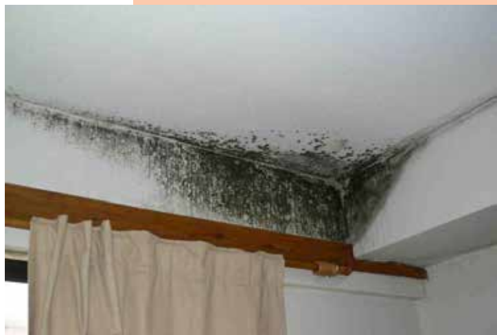
SLIKA 2: PLESEN V STANOVANJU. VIR: HTTP://WWW.DELOEDOM.SI/ENOSTANOVANJSKE-HISE/DOM-BREZ-VLAGE-PREMISLJENO-NAD-MADEZE-PLESEN .
